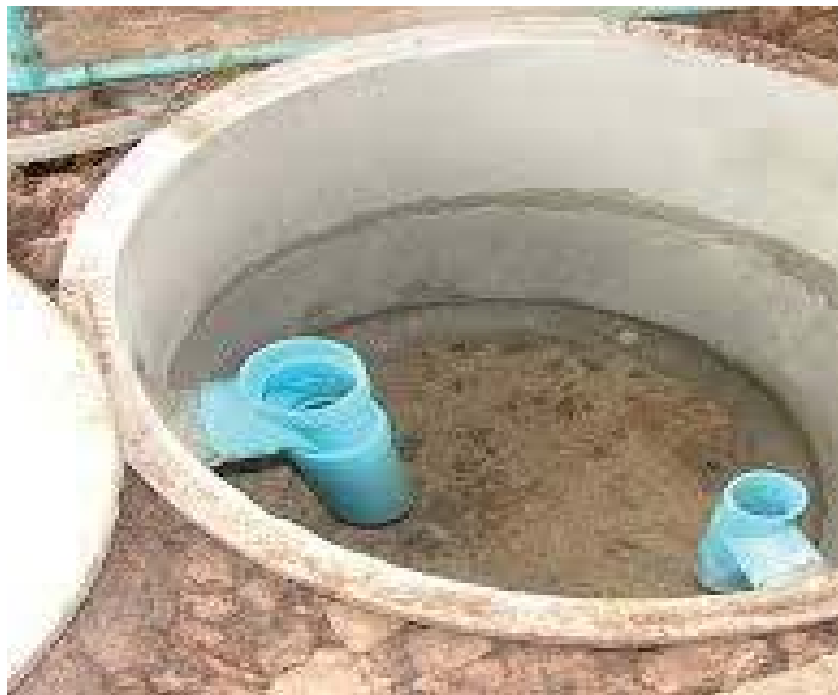
บ่อดักไขมันแบบใช้วงขอบซีเมนต์ (สำหรับที่พักอาศัย)
